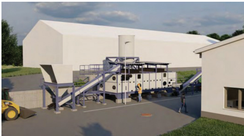
Obrázok 4: Projektovaná pásová sušička palivových štiepok na NLC
